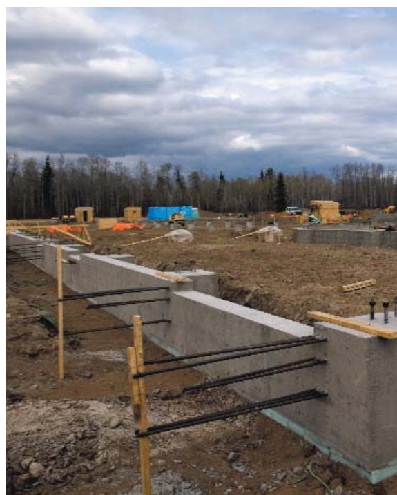
上：赫斯基的第一項油砂項目展開新工程。 右：瀝青混和稀釋液後，即可貯存在傳統油缸內。 下：赫斯基的轉化重油設施，把來自瀝青的石油化為優質石油。
