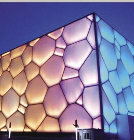
這座建築物的外貌看來好像由許多巨大的藍色肥皂泡組成，因此也被稱為「水立方」。這座建築物採用半透明的ETFE(乙稀和四氟乙稀共聚物)材料，使外牆的顏色可不斷轉變。
