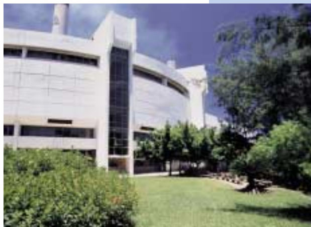
南丫發電廠的行政大樓。
